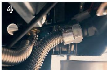
4) Anschluss Wellenschlauch an Ventileinheit (der Anschluss befindet sich auf der rechten Seite unter der Bedienblende)
